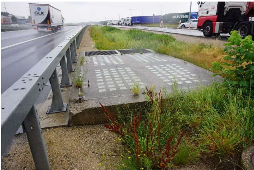
Abb. 8 Lichtschacht und Seitenschacht
