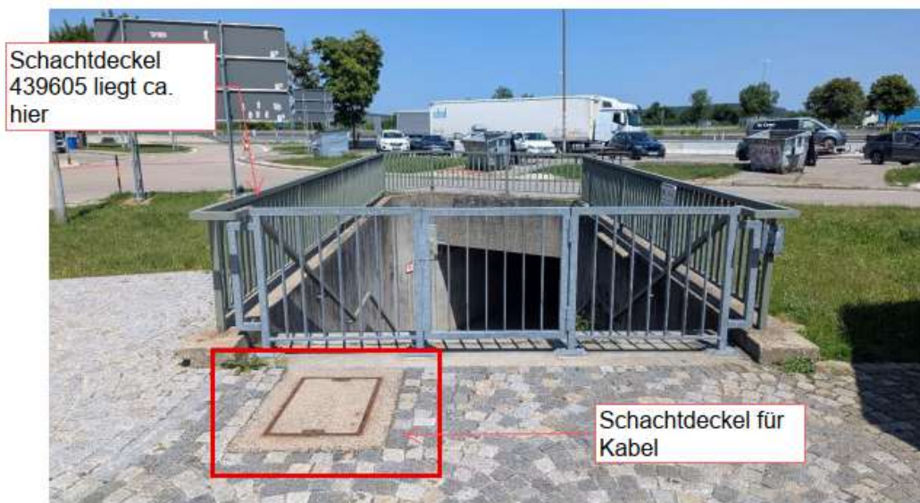
Abb. 5 Zugangsbauwerk West mit Schachtabdeckungen
