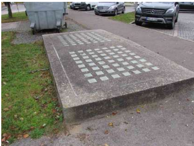
Abb. 9 Lichtschacht neben Verkehrsanlage
